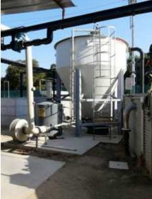
La planta funciona en continuo con un control permanente de los parámetros de funcionamiento y, dada la escasez de Nitrógeno como nutriente, semanalmente se realizan adiciones puntuales de cloruro amónico.
